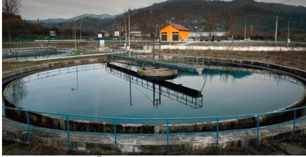
Balık Üretim Tesisi, Călărași, Romanya
